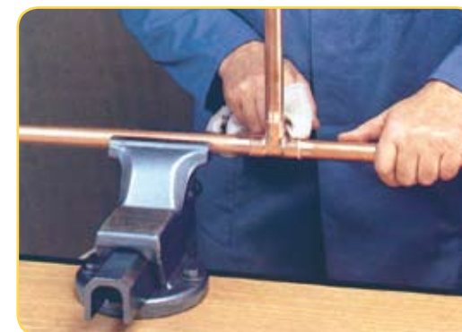
Figura 3.14. Limpieza del exceso de decapante
