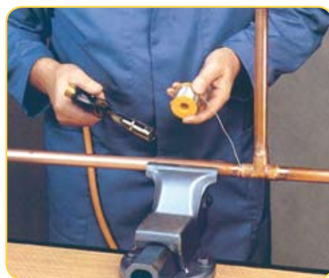
Figura 3.16. Aplicación de la soldadura
