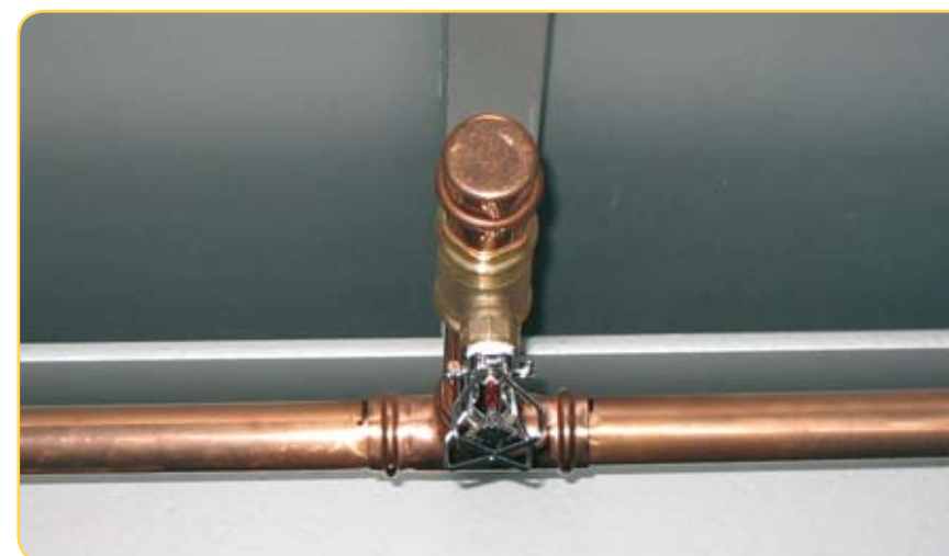
Figura 7.2. Instalación de rociadores con tubo de cobre
