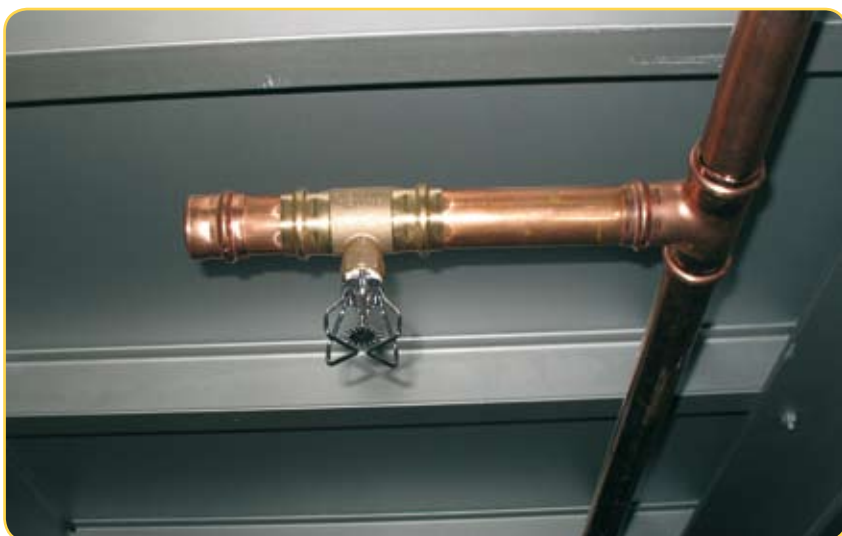
Figura 7.1. Rociadores automáticos
