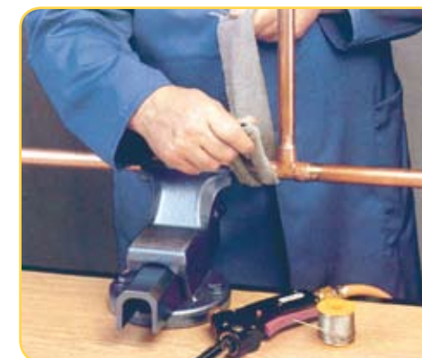
Figura 3.17. Enfriamiento y limpieza final
